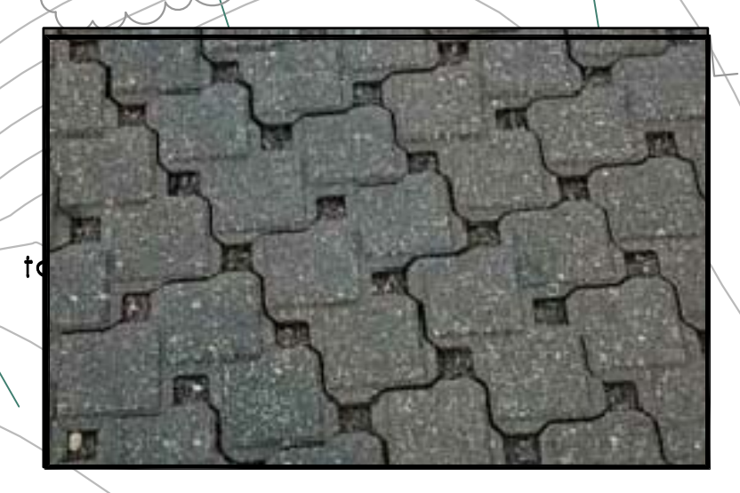
Permeable Entry Paving n.t.s.
